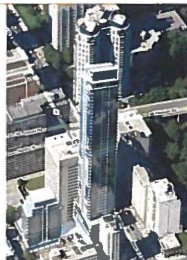
Faza finală a lucrării
